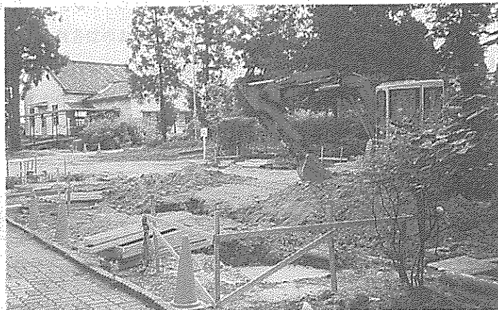
工事が進む食堂建設地（左奥の建て物は現在の食堂）
